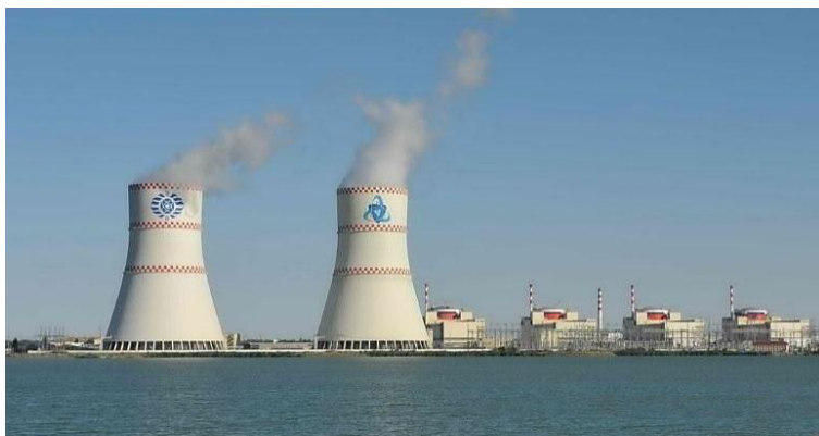
Рисунок 1 – Вид на Ростовскую АЭС с водоема-охладителя [View of the Rostov NPP from the cooling pond]
