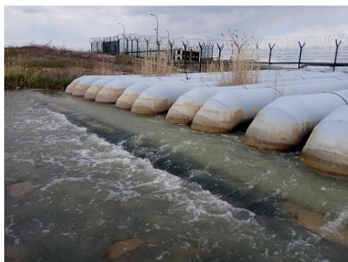
Рисунок 2 – Место сброса продувочных вод из водоема-охладителя в Цимлянское водохранилище [Place of discharge of blowdown water from the cooling reservoir into the Tsimlyansk reservoir]
