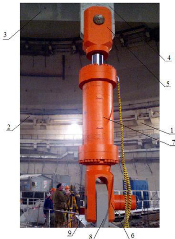
Рисунок 1 – Гидронагружатель: 1 – консоли защитной герметичной оболочки; 2 – подкрановые балки; 3 – пролетная балка моста крана; 4 – серьга главного подъема крана; 5 – верхняя вилка гидронагружателя; 6 – нижняя вилка гидронагружателя; 7 – цилиндр гидронагружателя; 8 – серьга траверсы; 9 – траверса [Hydraulic loader: 1 – console protective sealed shell; 2 – crane girders; 3 – span of the crane bridge; 4 – an earring of the main crane lifting; 5 – upper fork of the hydraulic loader; 6 – bottom hydraulic forklift; 7 – hydraulic loader cylinder; 8 – traverse earring; 9 – traverse]
