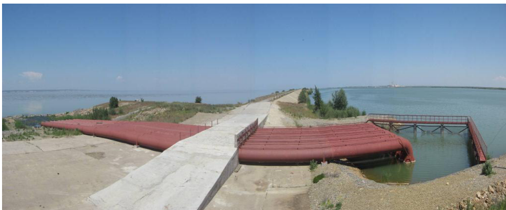
Рис. 1. – Сифонный водосброс водоёма-охладителя Ростовской АЭС
