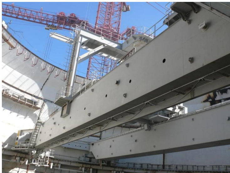
Рис. 4. – Установка крана на рельс
