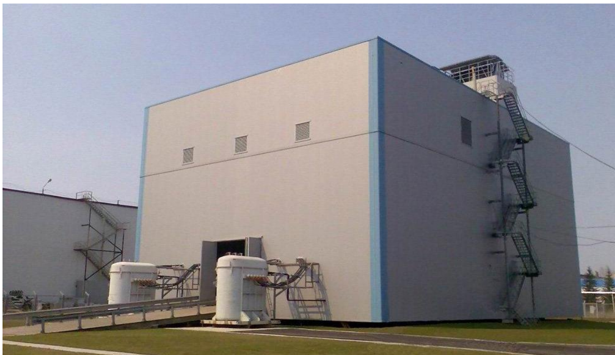
Рисунок 1– Вид газотурбинной теплоэлектростанции
