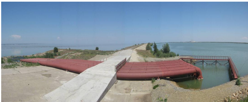
Рисунок 1 – Сифонный водосброс водоёма-охладителя Ростовской АЭС
