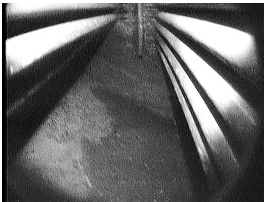
Рис. 4. Парогенератор после очистки
