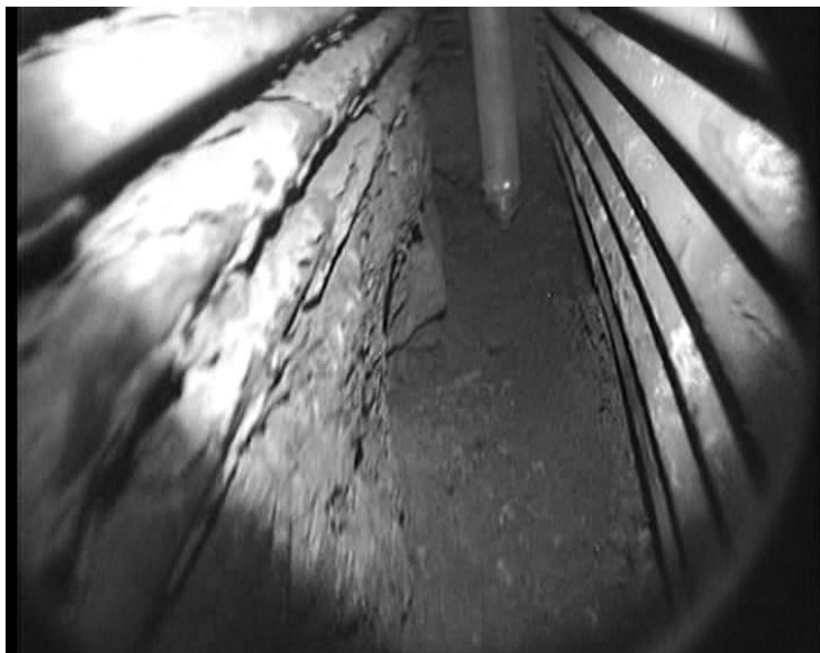
Рис. 2. Результаты очистки днища парогенератора от шлама вакуумным методом на сухую
