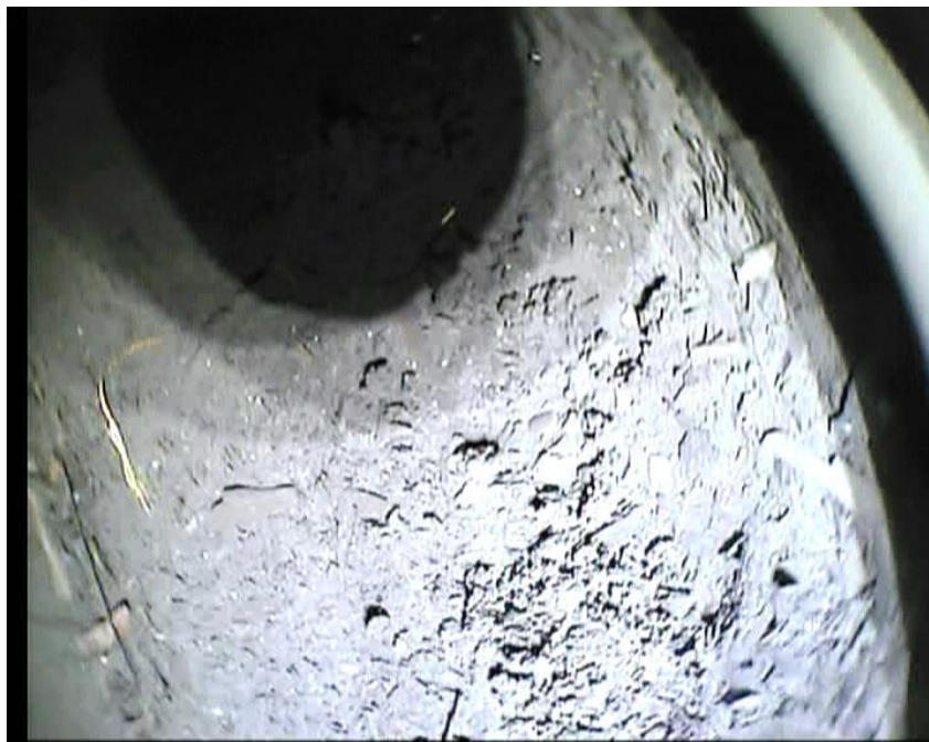
Рис. 3. Парогенератор перед очисткой
