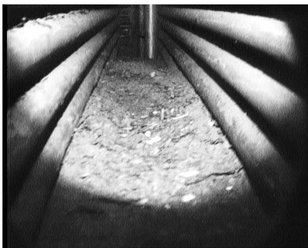
Рис. 1. Шлам в межтрубном коридоре парогенератора за первой, от «горячего» коллектора, дистанционирующей решёткой
