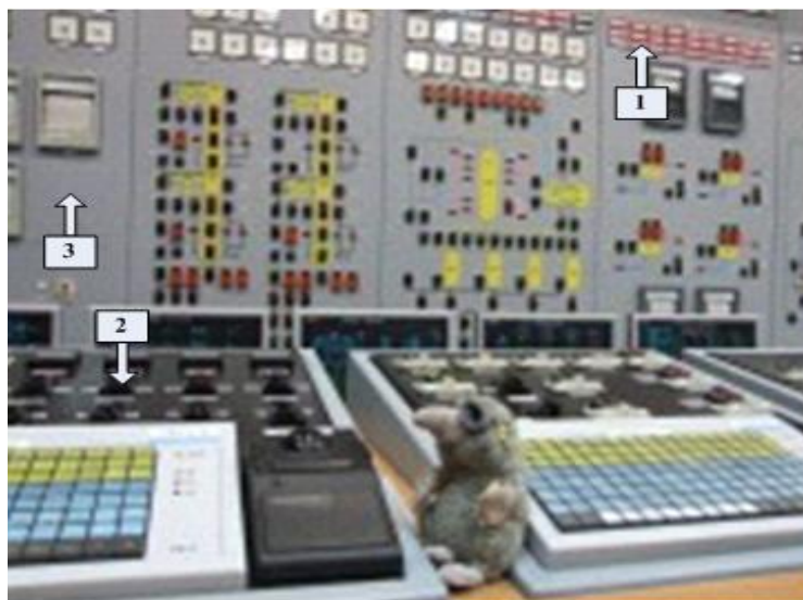
1 – размещение детекторов в резервных приборных посадочных местах модели БЦУ, 2 – размещение детекторов в оборудовании на рабочей панели, 3 – размещение детекторов в свободных ячейках модели БЦУ
